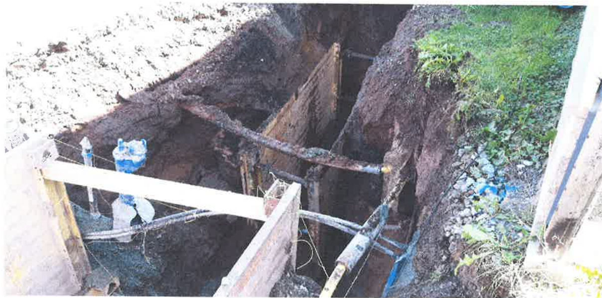
Výstavba kanalizace - Běloves Náchod
