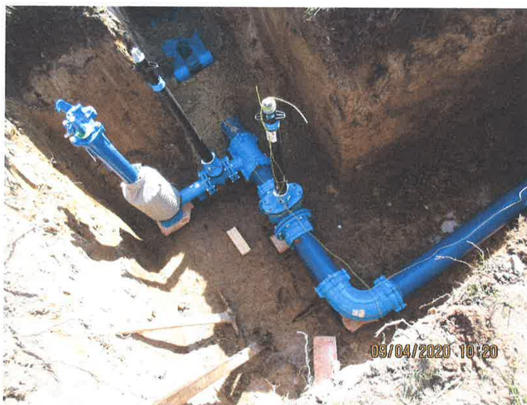
Výstavba vodovodu – Mezilečí
