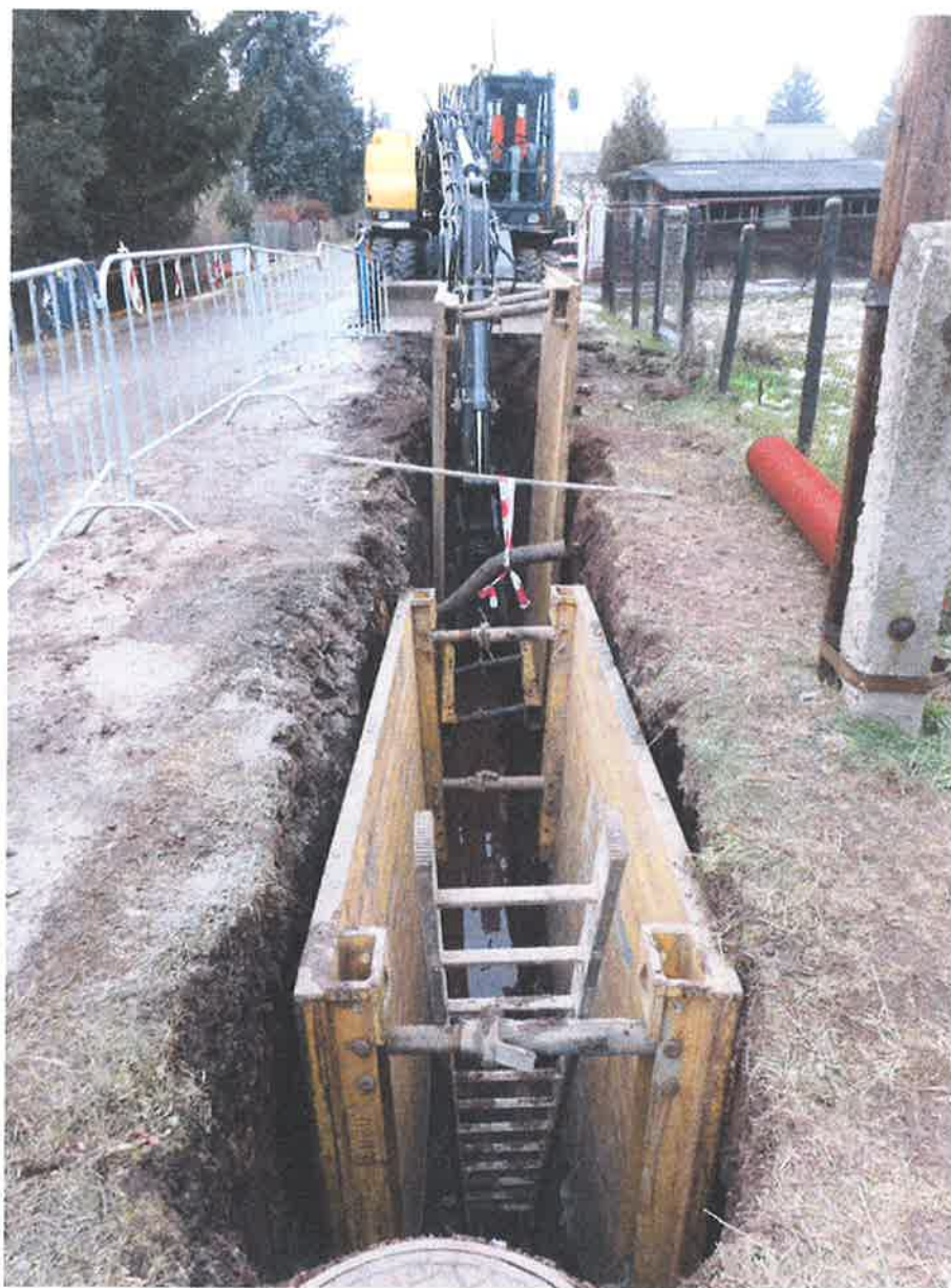
Výstavba kanalizace Broumov
