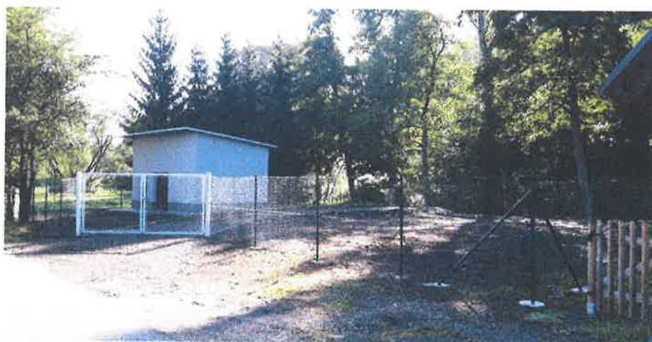
Čerpací stanice – Zdoňov
