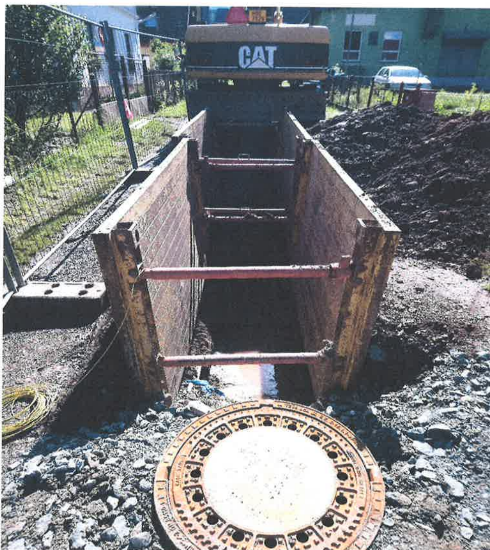
Výstavba kanalizace v ul. Hvězdecká - Broumov.
