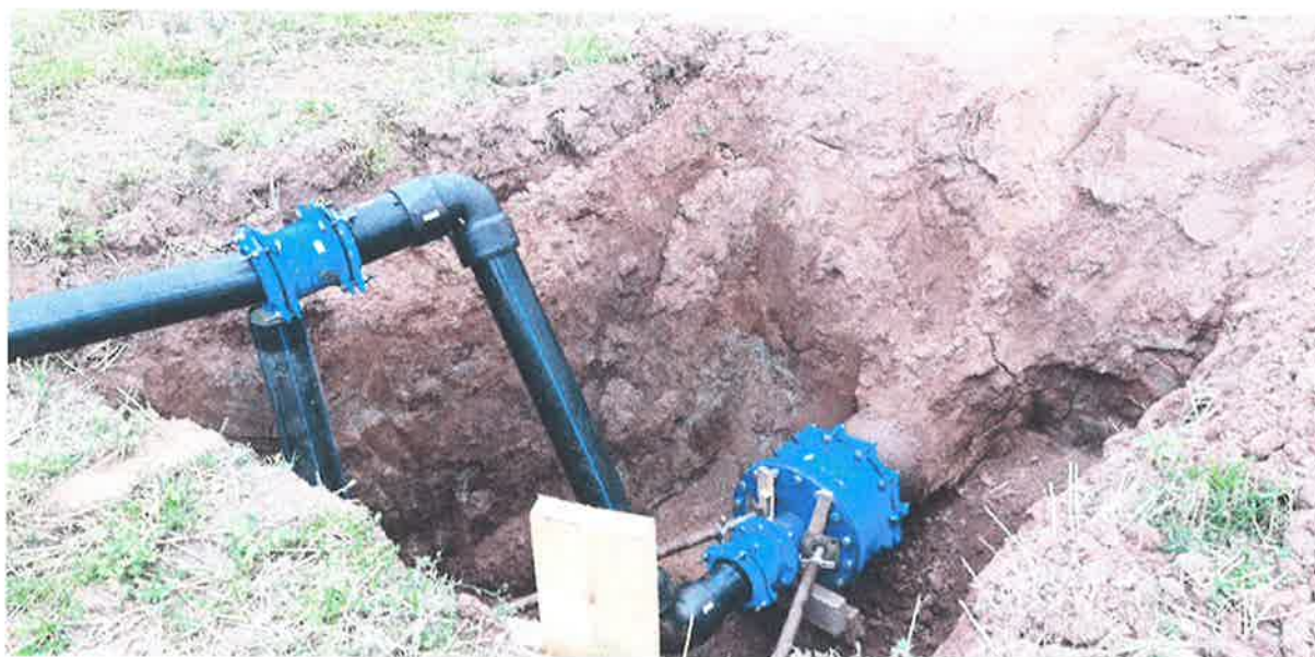
Oprava přivaděče v Hejtmánkovicích
