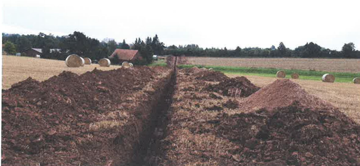
Výstavba vodovodu Křižanov.
