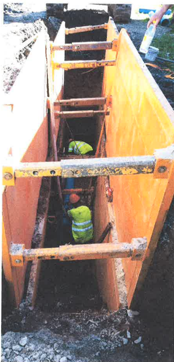
Výstavba kanalizace ul. Hvězdecká Broumov
