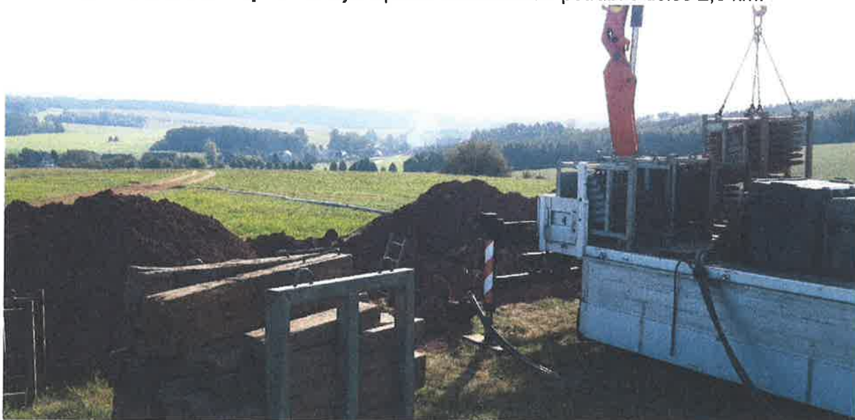
Oprava přivaděče v Jetřichově
