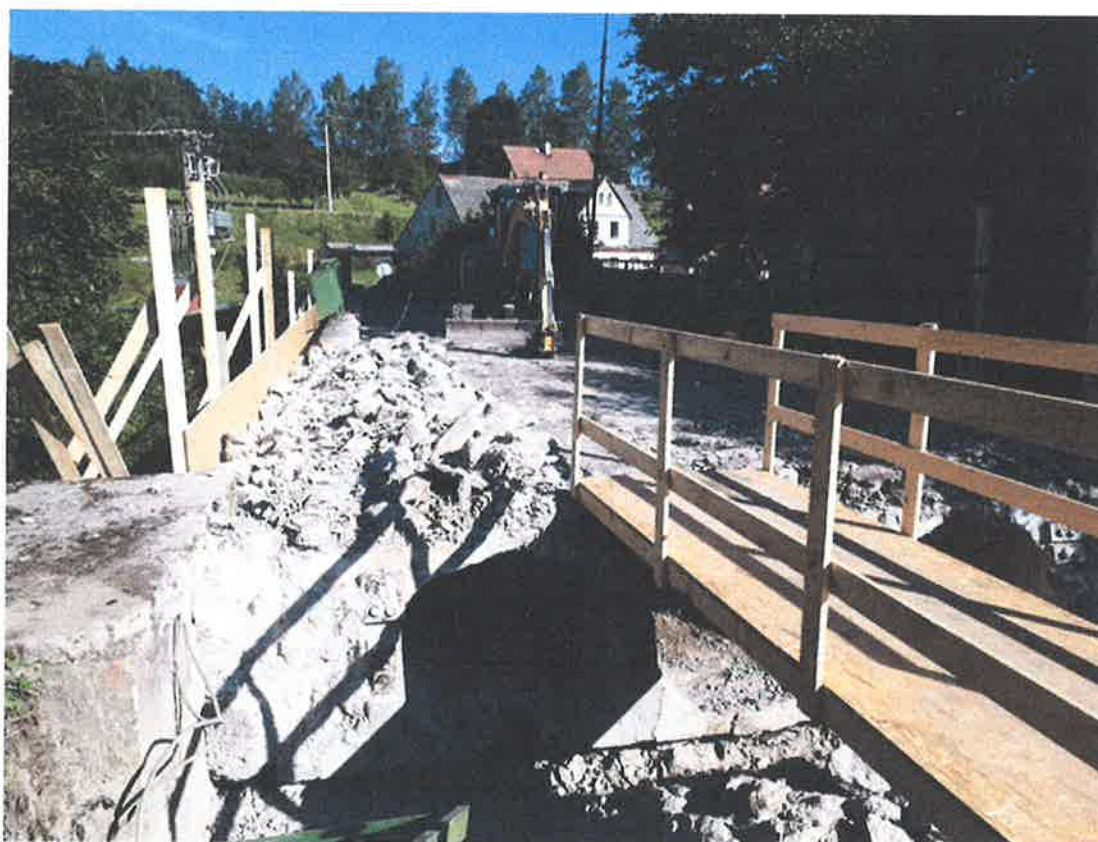
Rekonstrukce mostu – ČOV Teplice nad Metují
