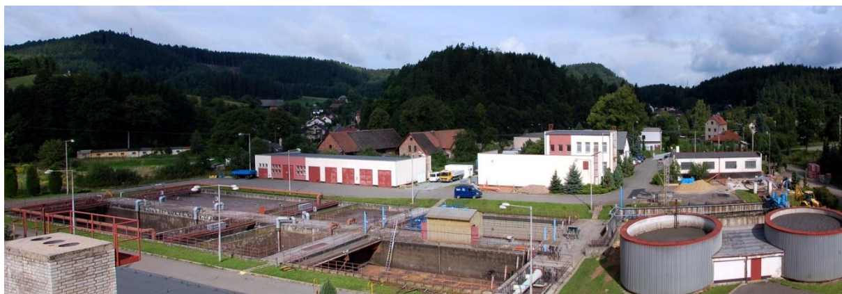
obrázek č.2 - Pohled na ČOV Náchod - Bražec - VAK Náchod, a.s.
