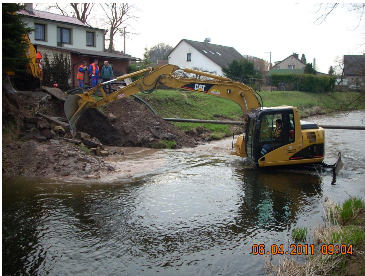
Obrázek č.7 - výstavba kanalizační shybky ve Velkém Poříčí - VAK Náchod, a.s.
