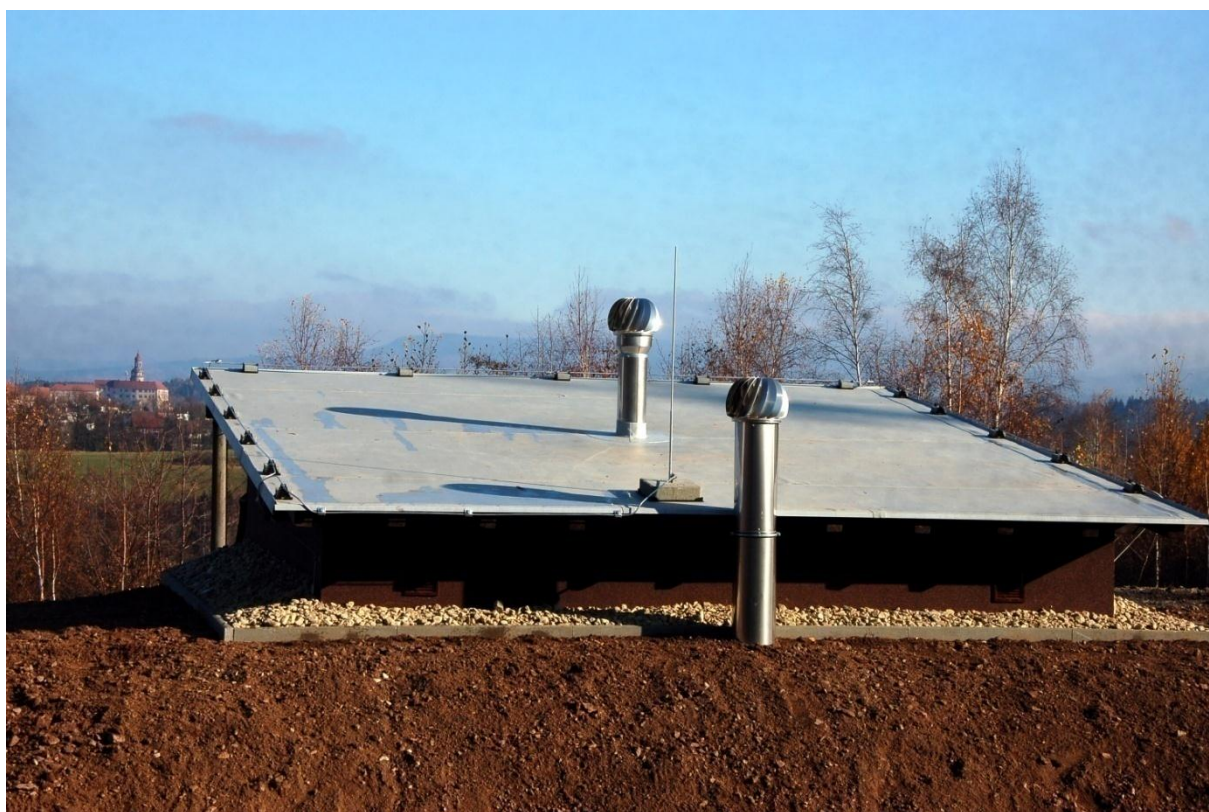
obrázek č.4 - Pohled na VDJ Branka I – 2 x 500 m 3 - VAK Náchod, a.s.
