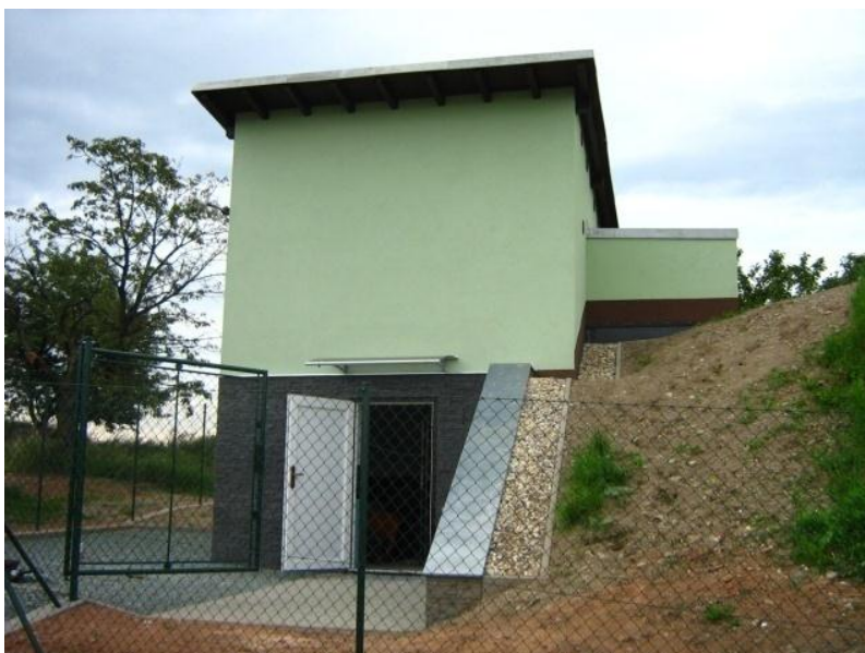
obrázek č.1 - VDJ Příbyslav - po rekonstrukci
