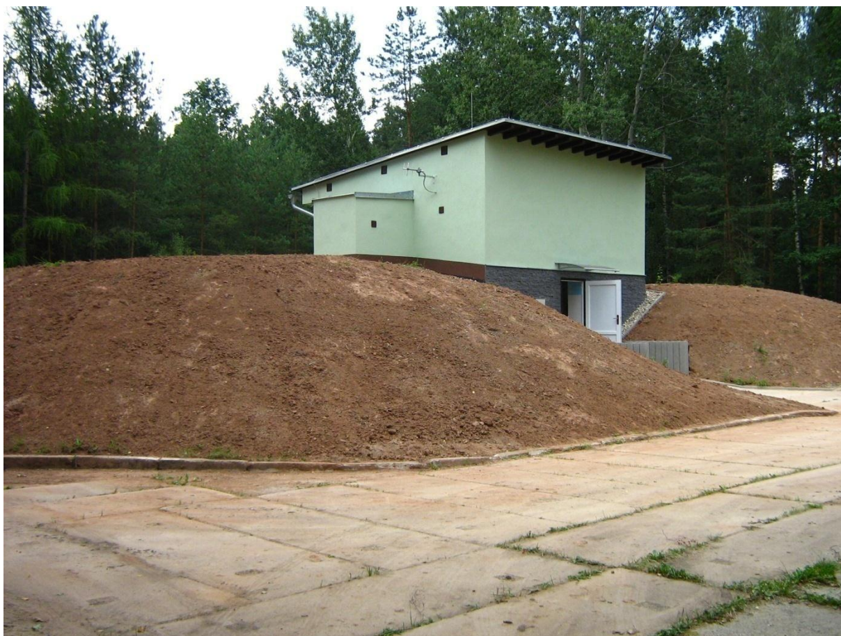
Obrázek č.5 - VDJ Horka po rekonstrukci – VAK Náchod, a.s.
