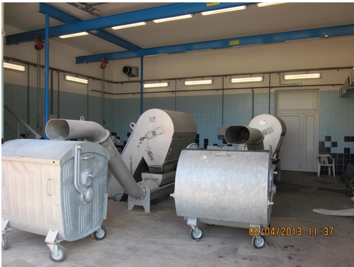
Obrázek č. 8 – Pohled na česlovnu, ČOV Náchod
