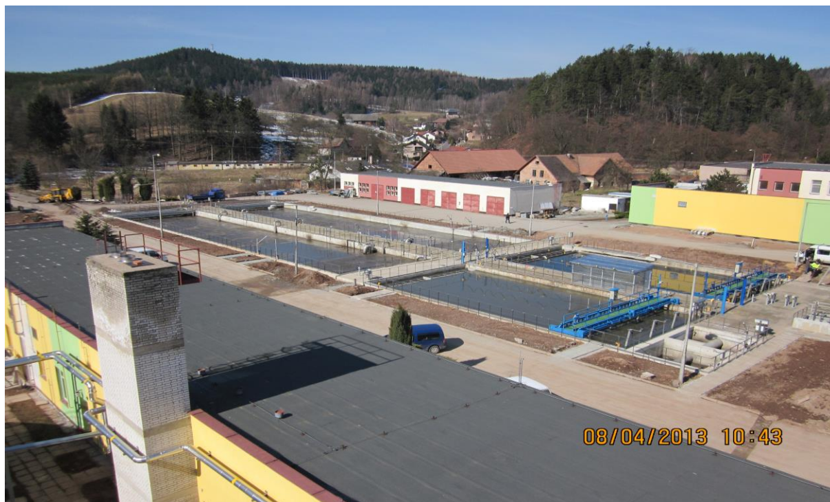
Obrázek č. 5 – Pohled na ČOV Náchod – Bražec, Náchod
