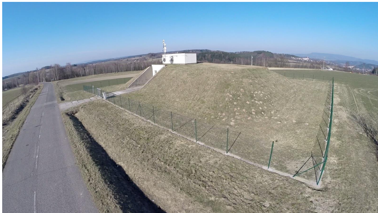
Obrázek č. 6 – Pohled na VDJ Vysokov, Náchod
