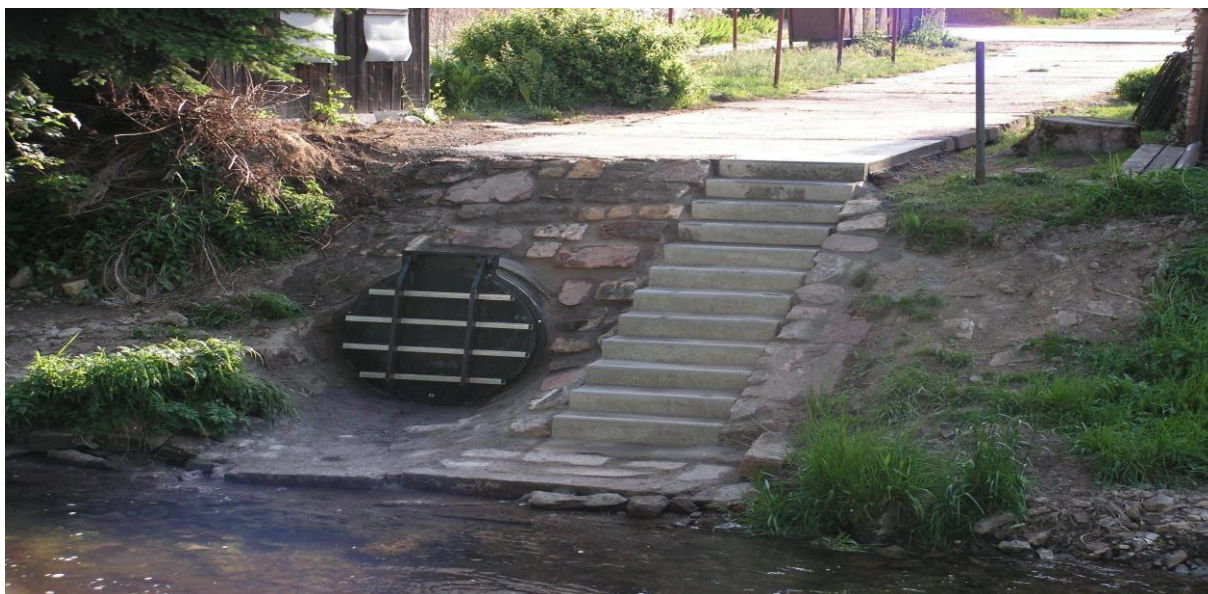
Obrázek č. 10 – Pohled na vyústění odlehčovací stoky, kanalizace Velké Poříčí
