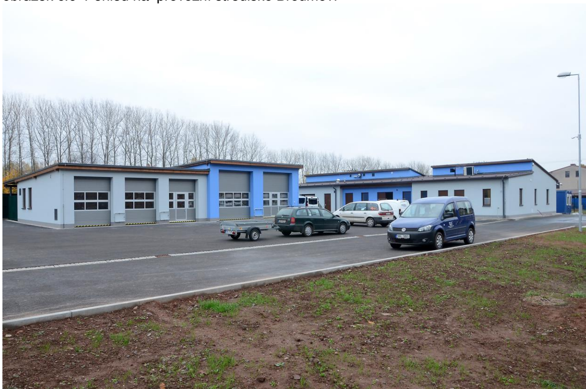
obrázek č.6 Pohled na provozní středisko Broumov.
