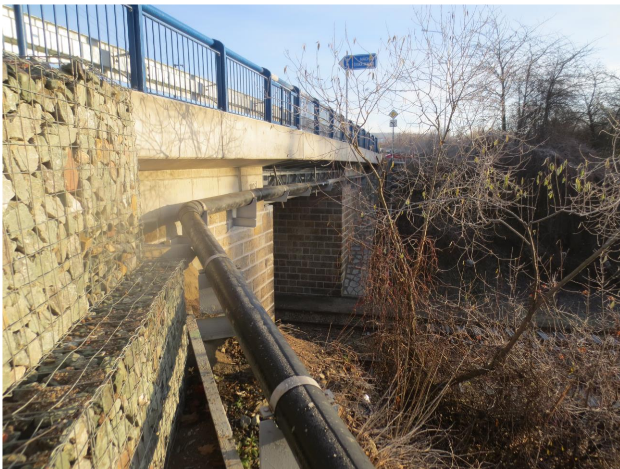
obrázek č.5 Pohled na vodovod zavěšený na mostě v Krčíně
