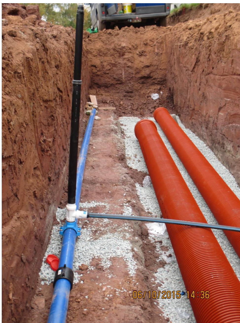
Obrázek č.11 - výstavba vodovodu, splaškové, dešťové kanalizace ve Zbečniku.
