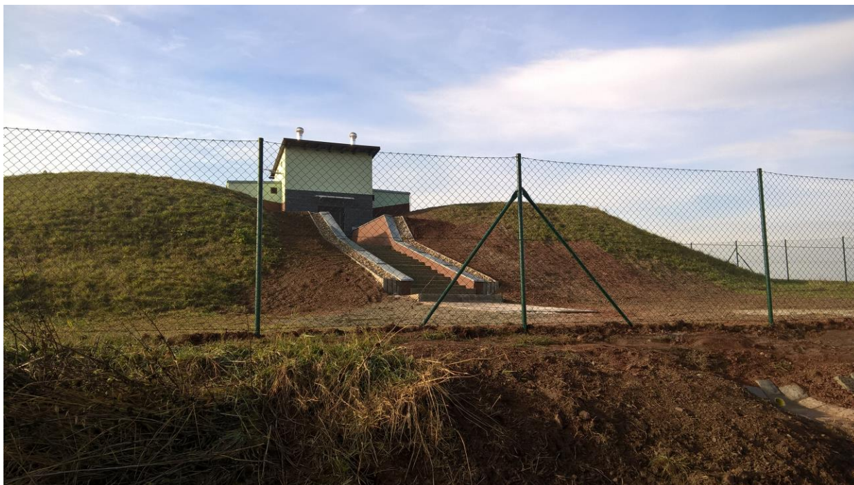
obrázek č.2 Pohled na VDJ Vernéřovice
