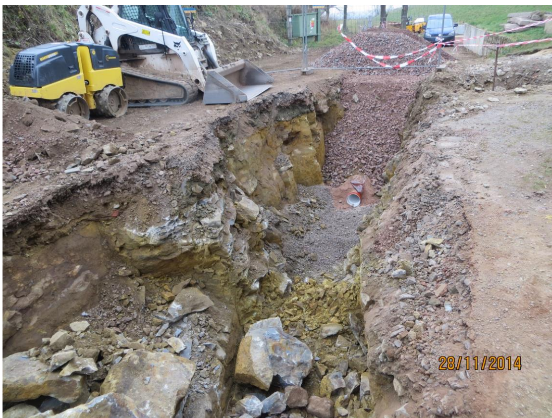
Obrázek č.9 Výstavba splaškové kanalizace v Teplicích nad Metují.
