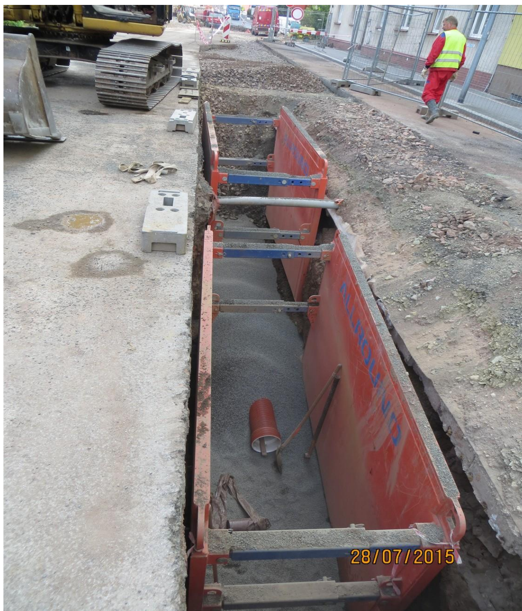
Obrázek č.10 Výstavba jednotné kanalizace v ul. Raisově, Náchod.
