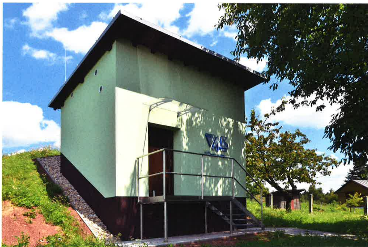
Vodojem s čerpací stanicí Klínek- Náchod
