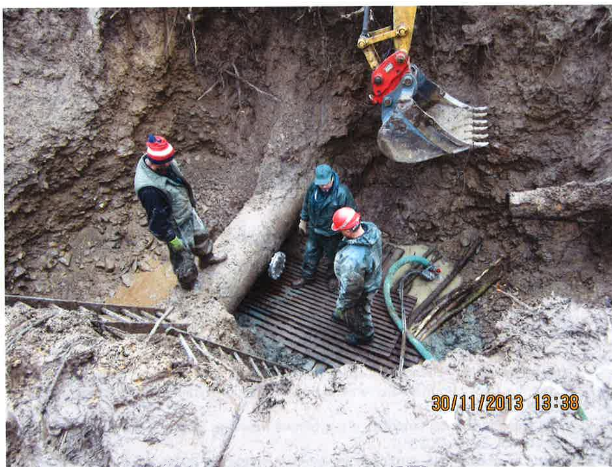
Obrázek 7 oprava přivaděče VSVČ –Vysoká Srbská
