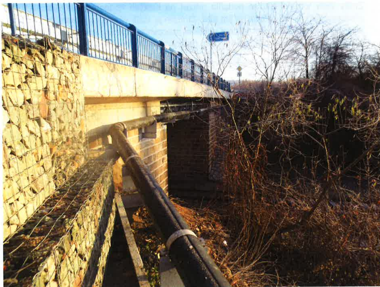
Obrázek 4 nový vodovod na sil. mostu Krčín – Nové Město nad Metují
